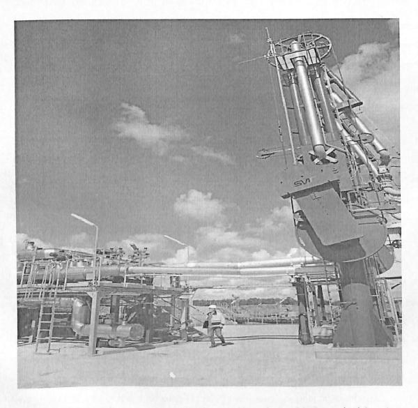
Fig-13 LNG Unloading arm
